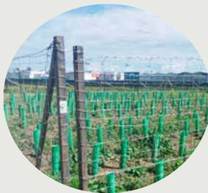
INSTALACIÓN DE VALLADO
