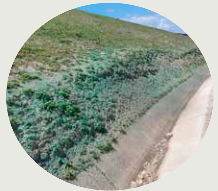
HIDROSIEMBRA DE TALUDES
